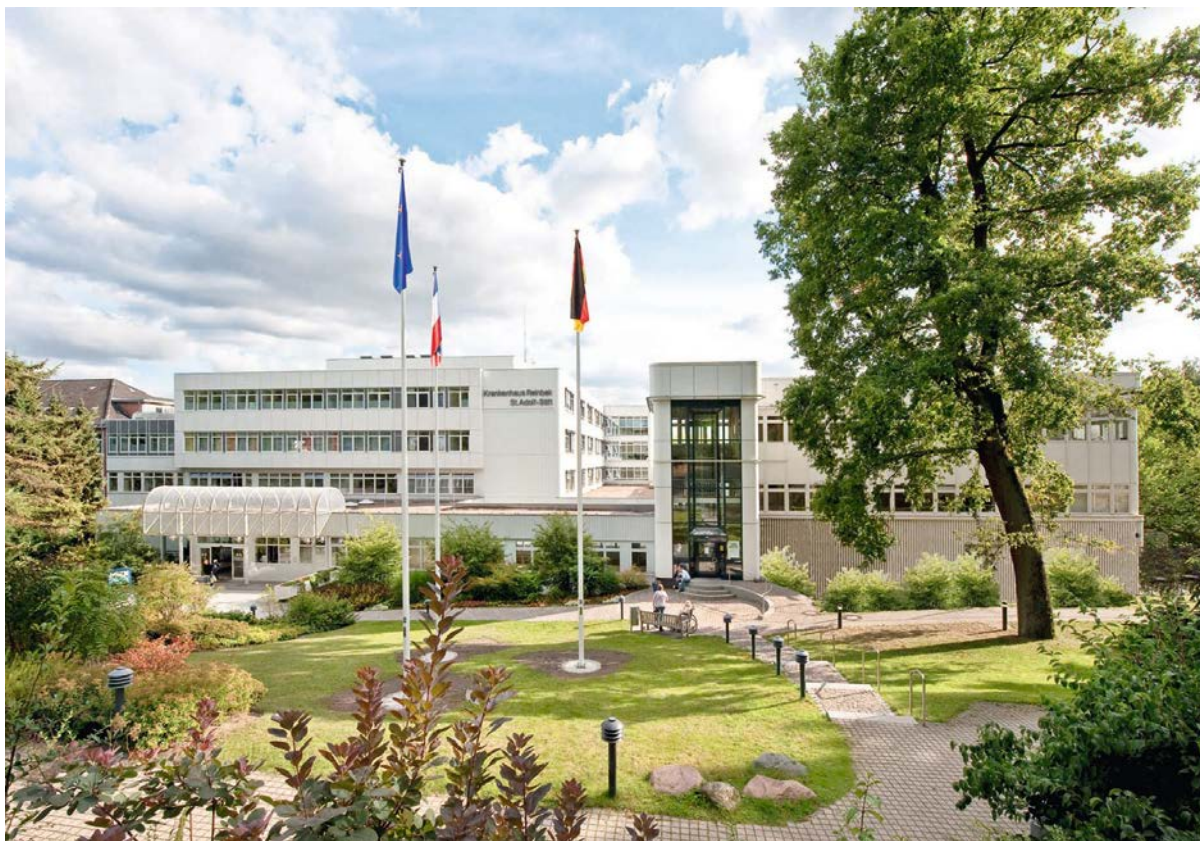
Ansicht des Krankenhauses Reinbek
